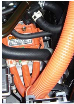
Branchement des câbles haute tension au moteur électrique
